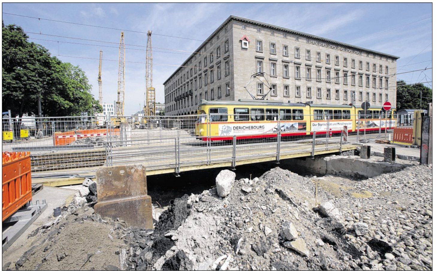
ÜBER DIESE BRÜCKE darf die Holzklasse der Linie 5 noch bis kurz vor Weihnachten mitten durch die Stadt rollen. Dank dieses Provisoriums stellt die U-Strab-Grube in der Ettlinger Straße kein Hindernis für die Straßenbahn dar. Foto: jodo
